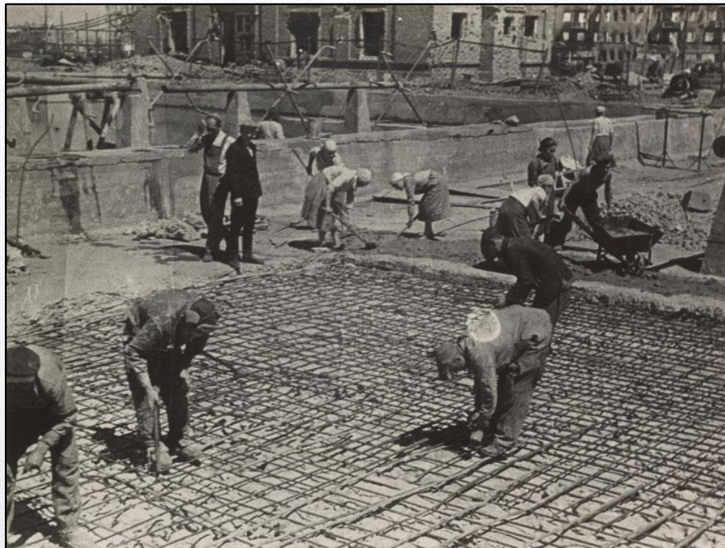
Работы по восстановлению ТЭЦ Сталинградского тракторного завода. 1943 г.
